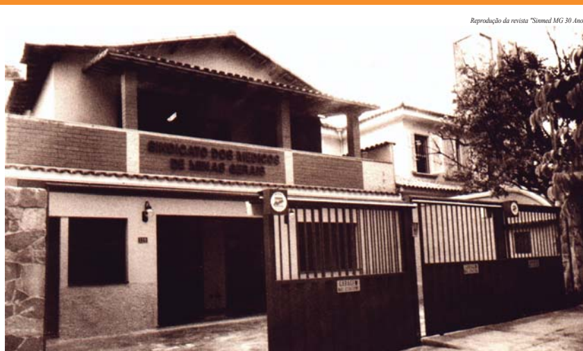
Mudança para a nova sede aconteceu em 1989. Foto do prédio antes da reforma.
